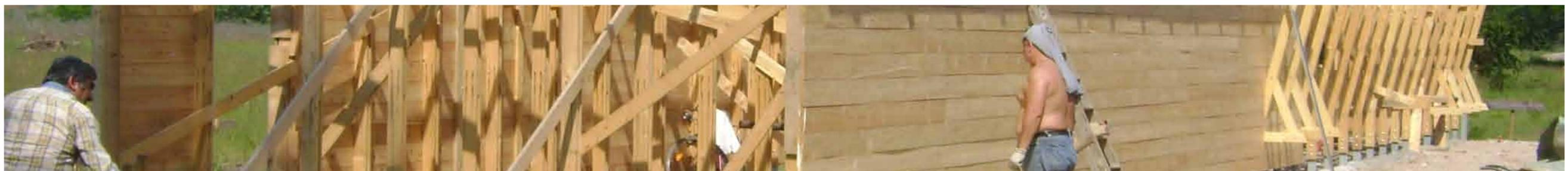
Ciascun elemento può essere assemblato da terra, lavorando in perfetta sicurezza (non è richiesto l'uso di scale o ponteggi). Anche l'utilizzo di mezzi meccanici è ridotto al minimo, un piccolo escavatore ha realizzato gli scavi di fondazione e piccoli riporti di terreno, tutte le operazioni successive sono state realizzate direttamente dagli ortisti.
